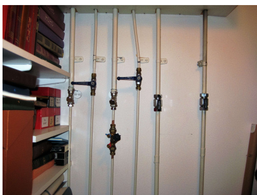
Bild 2. Placering av ventiler inne i klädkammaren i en 2 rumslägenhet, avstängningen för kall- och varmvattnet är de 2 högra ventilerna.
