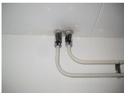
Bild 1a,b. Vanligaste placering av avstängningsventiler i taket på toaletten på nedervåningen
