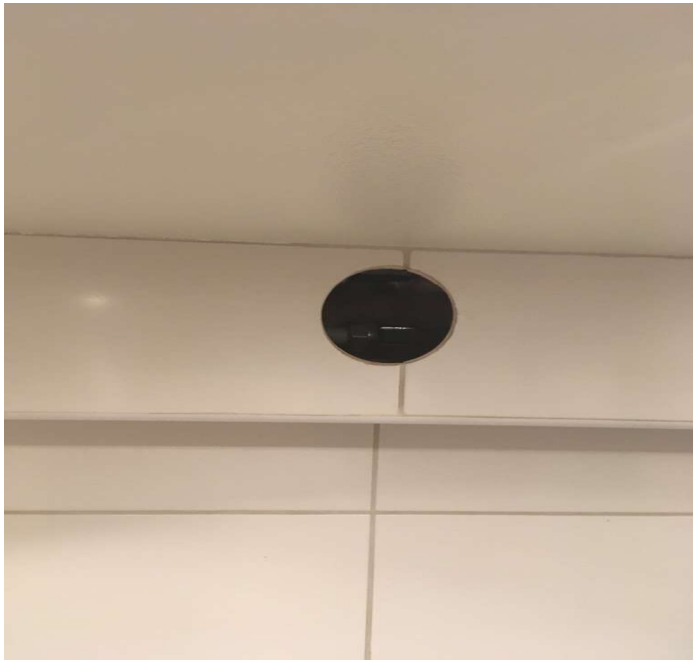
Bild 4a. Rören har byggts in och ventilerna är åtkomliga genom inspektionsluckan. Ursprungligt utseende se bild 1a
