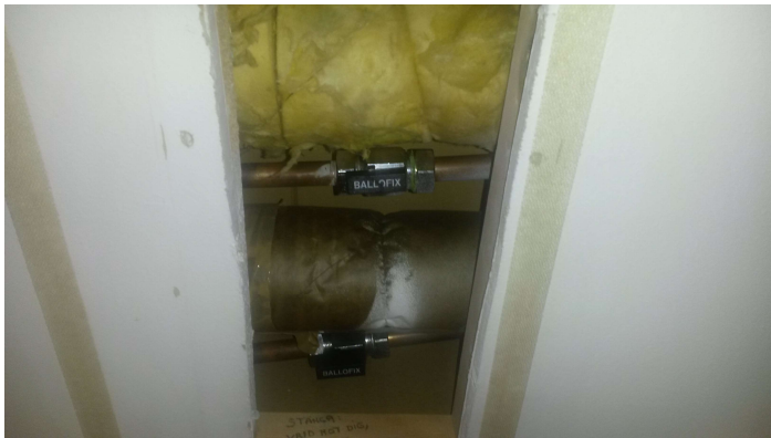
Bild 4b. Ventilerna finns inbyggda bakom en luckan i taket inne på toaletten på nedervåningen. Luckan sitter på trumman som går genom alla lägenheterna. Bakom luckan kan finnas 2 andra ventiler av annat utseende, dessa får ej röras.
