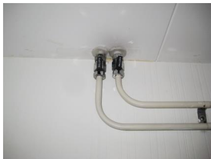
Vanligaste placering av avstängningsventiler i taket på toaletten på nedervåningen.
